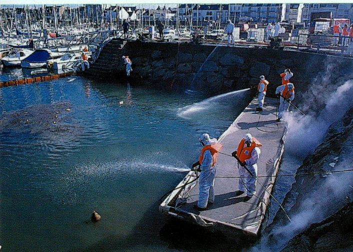
Chantier de nettoyage haute-pression de l'intérieur du port de La Turballe et confinement des effluents, mai 2000.
