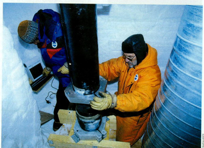
Mise en place de la gaine du tube du carottier au fond du trou de carottage.
