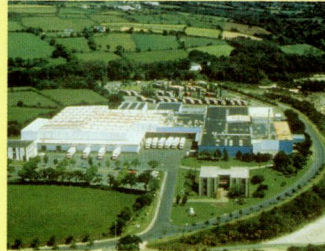
La société Tilly-Sabco vient de doter le site de Guerlesquin d'un nouveau bâtiment d'abattage de 2 200 m 2 qui permet désormais d'abattre 340 000 poulets par jour.
