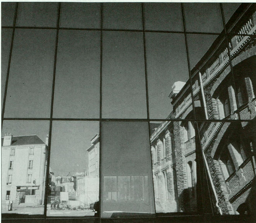
L'administration régionale "Bretagne-Pays de la Loire" à Rennes.
