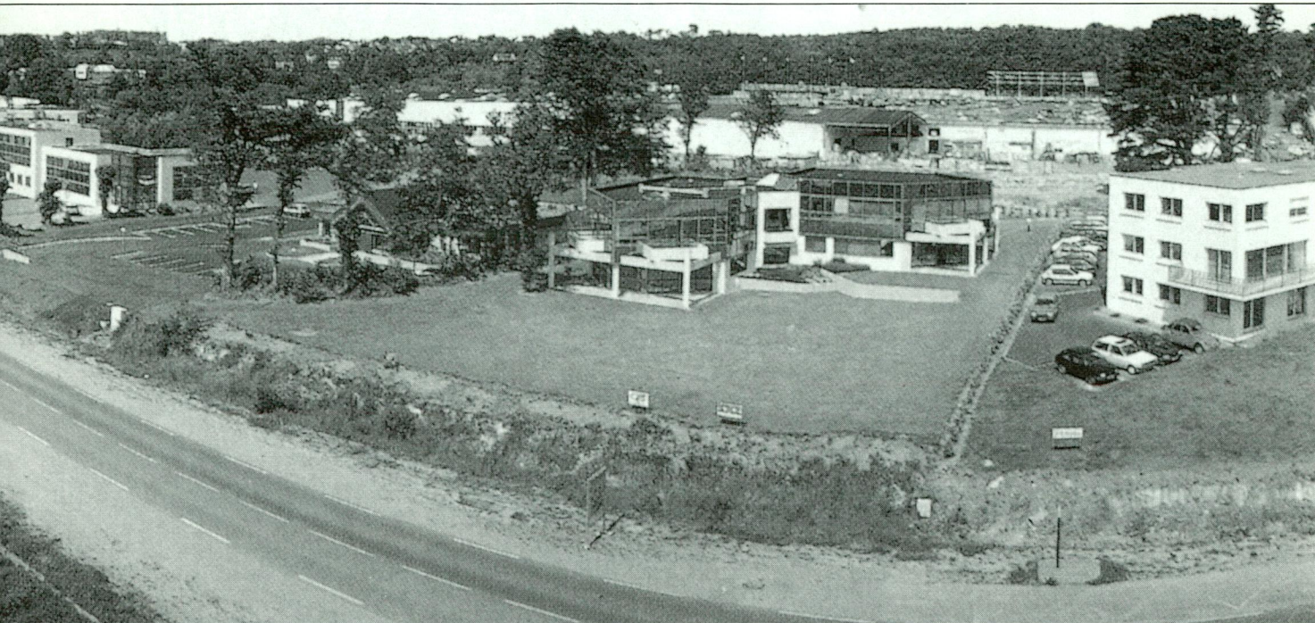
Le pôle d'innovation Quimper-Atlantique. A gauche, la pépinière d'entreprises.
