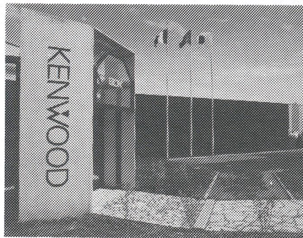
L'usine SDK à Janzé.
